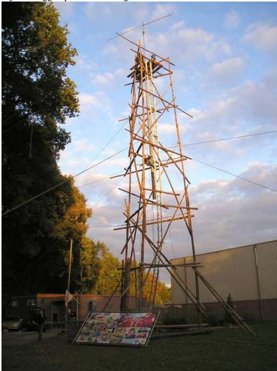
De gepionierde mast, 24m hoog op het platform
