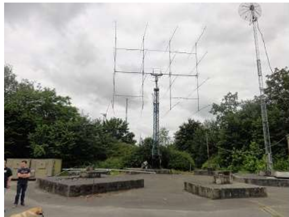
De twee meter antenne-installatie op één van de fundamenten van de radarinstallatie
