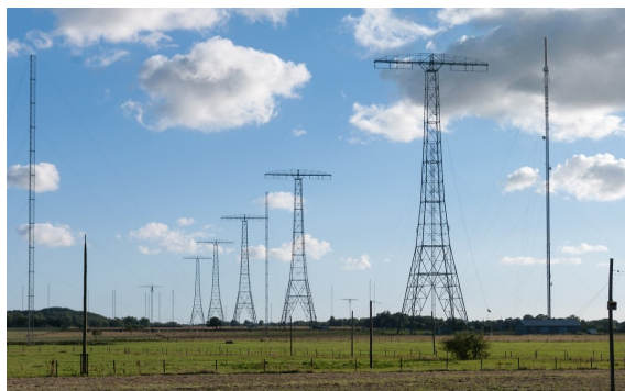
Het SAQ-antennesysteem, afgestemd op 17,2 kHz
