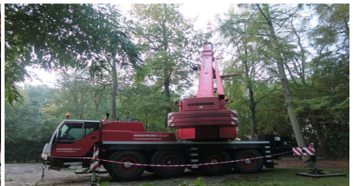
Een mobiele kraan als antennemast
