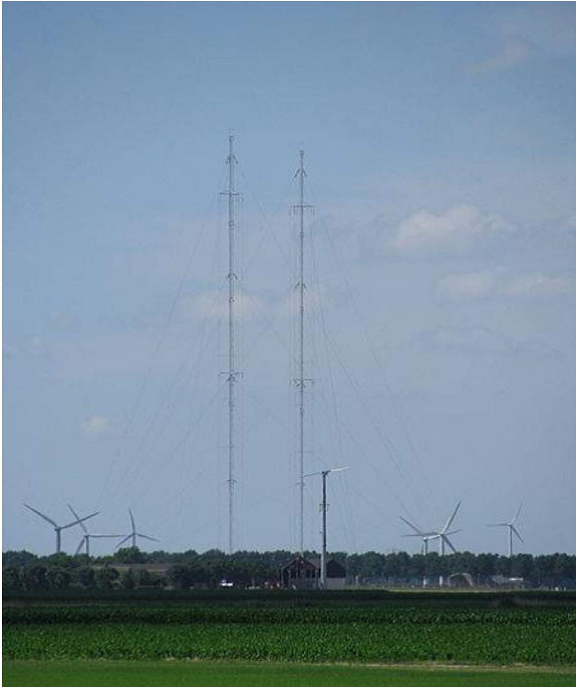
De bijna 200 meter hoge antennemasten van de AM-zenders in Zuidelijk Flevoland
