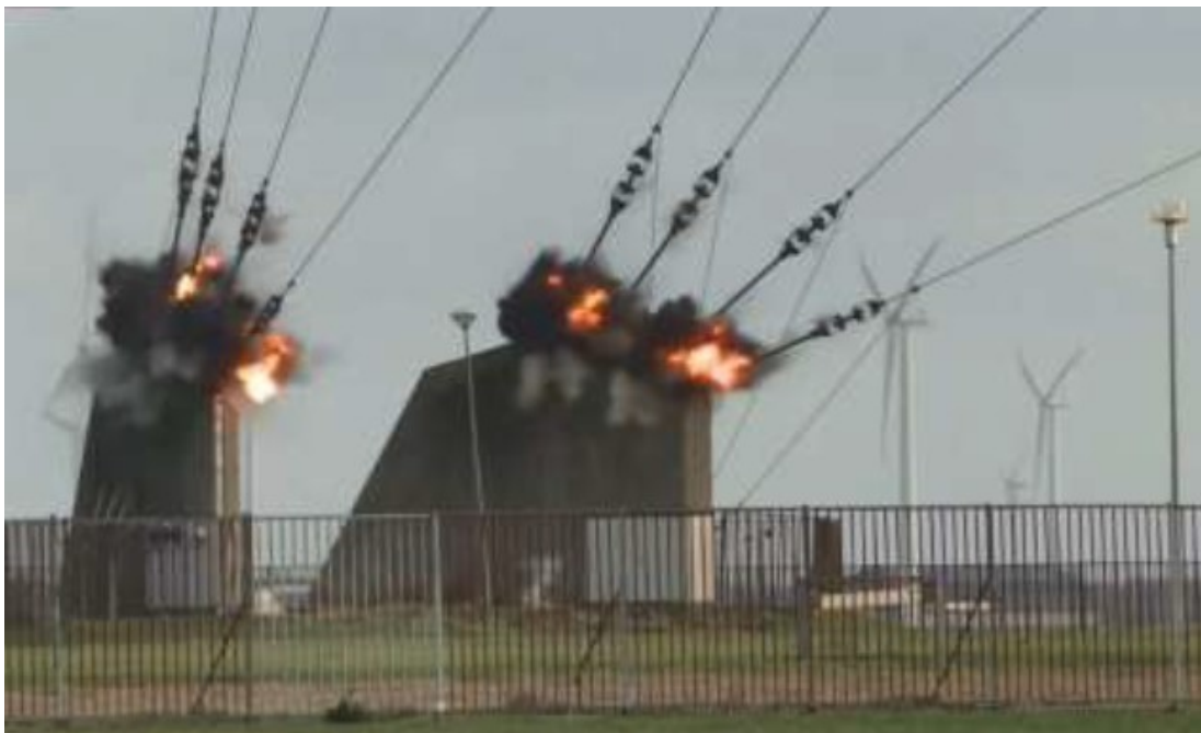
Slordig sloopwerk op 9 januari in Zuidelijk Flevoland
