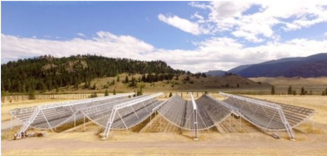
De vier 100 meter lange reflectoren van de CHIME telescoop
