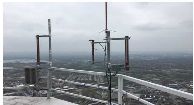
Het onderste deel van de Diamond X5000 antenne op de Gerbrandytoren op 220 meter hoogte
