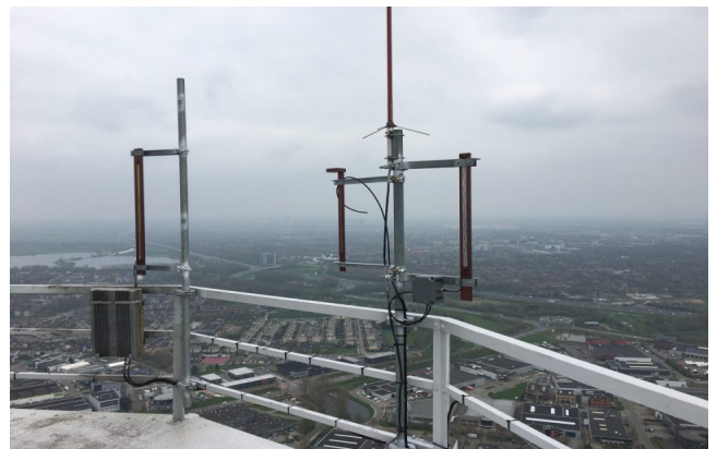
Het onderste deel van de Diamond X5000 antenne op de Gerbrandytoren op 220 meter hoogte
